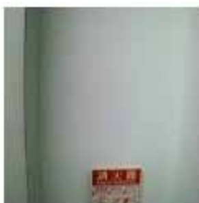
a. 壁 (鉄筋コンクリート)
